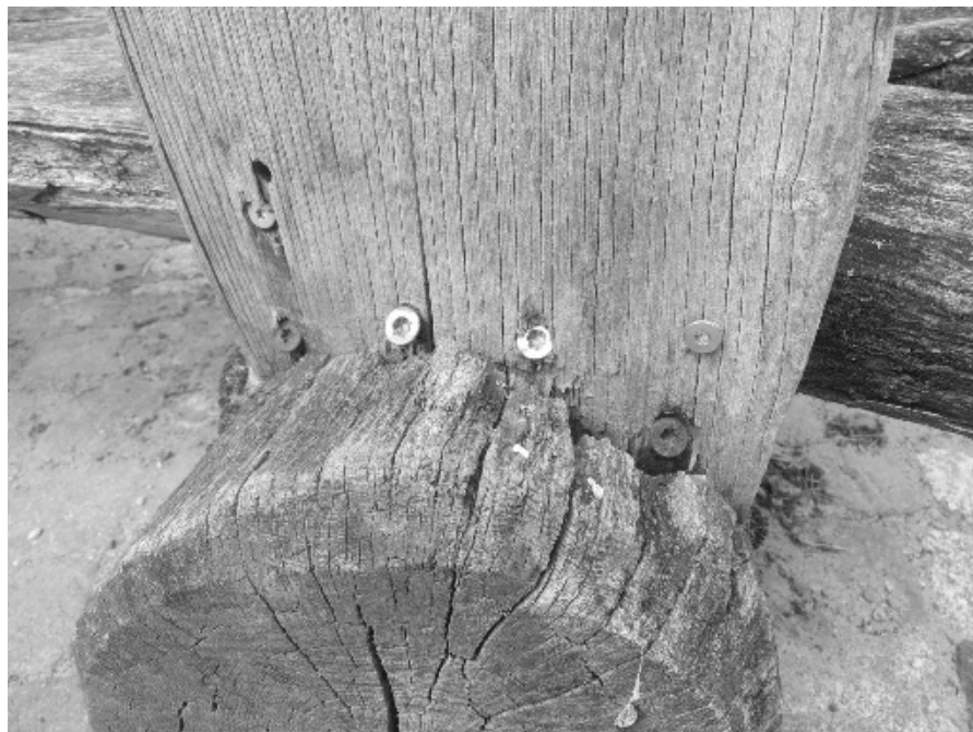
Abbildung 10: überstehende Schrauben Rückenlehne Bank Spielplatz Gänseweide/ Haardtweien
