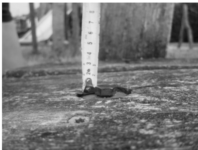
Abbildung 11a: überstehende Schrauben Sitzfläche Bank
