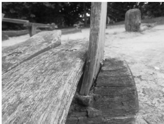
Abbildung 12a: wackelige Rückenlehne Spalt
