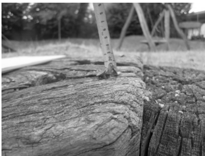
Abbildung 11: überstehende Schrauben Sitzfläche Bank
