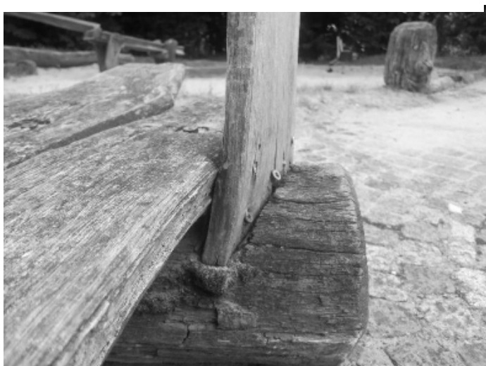
Abbildung 12: wackelige Rückenlehne Sltzbank
